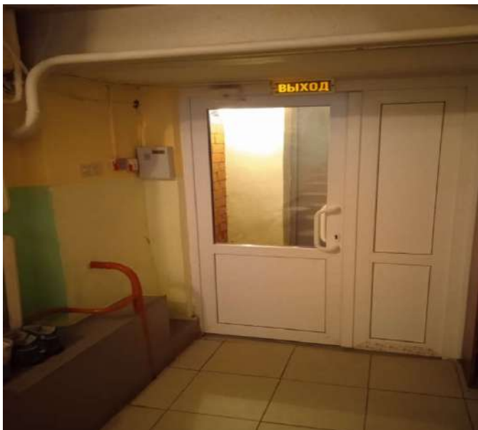
Фото №4 входная дверь
