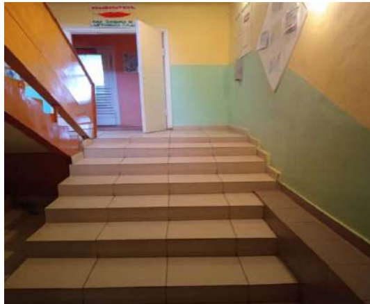
Фото №5 лестница внутри здания
