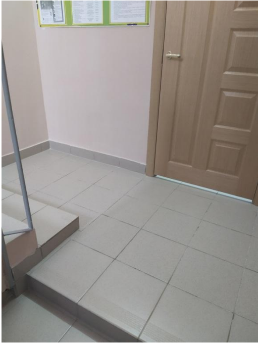
Фото № 5 Коридор, вестибюль
