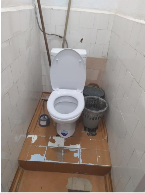
Фото № 8 Туалетная комната
