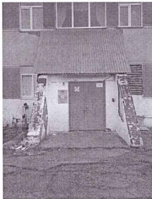
фото № 2 входная площадка
