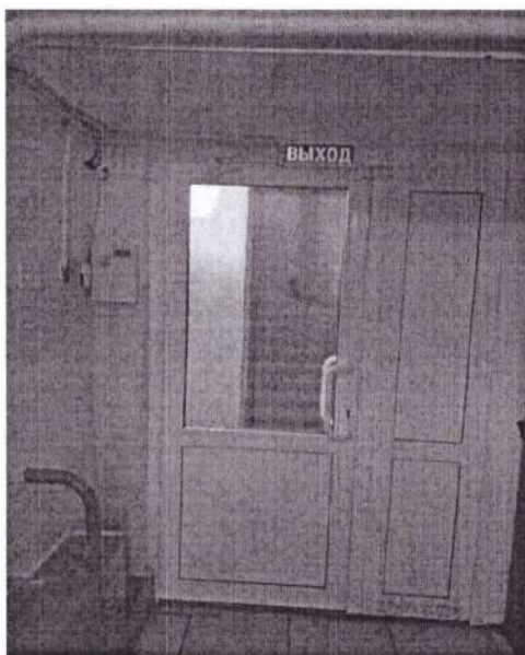
фото №7 входная дверь внутри здания
