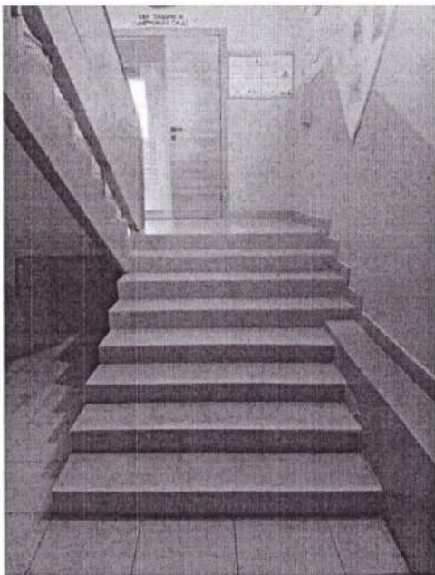
фото № 5 лестница внутри здания
