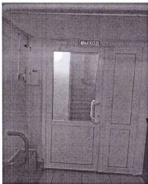
фото №3 дверь входная
